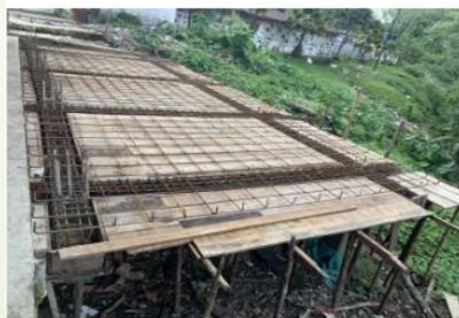
VISTA LOSA 50 BÓVEDAS ENCOFRADA Y ARMADA
